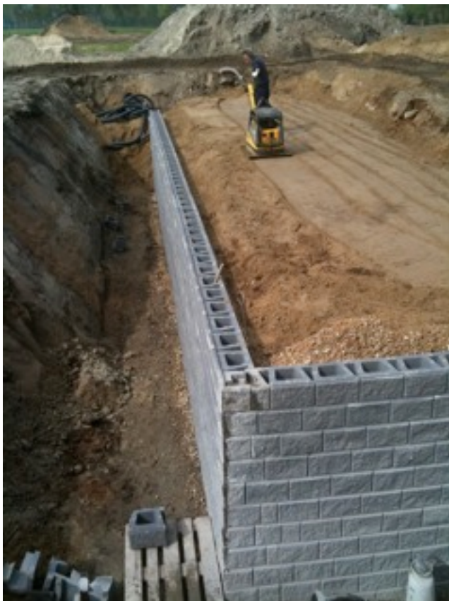
Totaal 730 m 2 Allan Blocks Maximaal kerende hoogte 3,40 m
