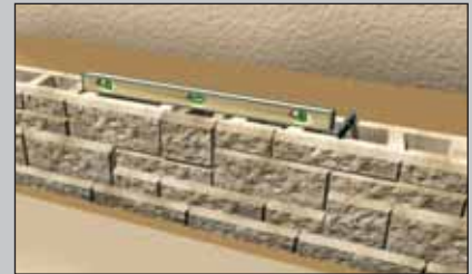
Afmaken van het wildverband patroon, waterpassen en uitlijnen
