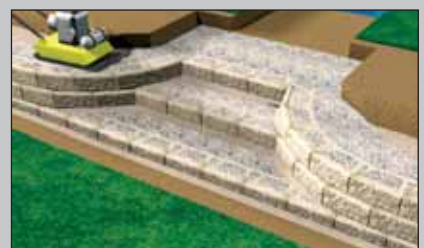
Aanvullen en verdichten
