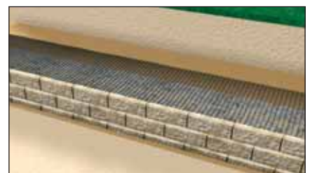
Plaats de volgende laag blokken met geogrid
