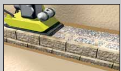
Aanvullen en verdichten
