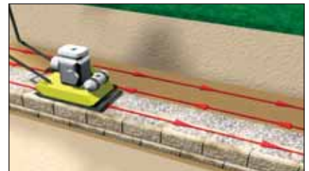
Aanvullen en verdichten
