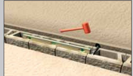
Uitrichten en waterpas zetten
