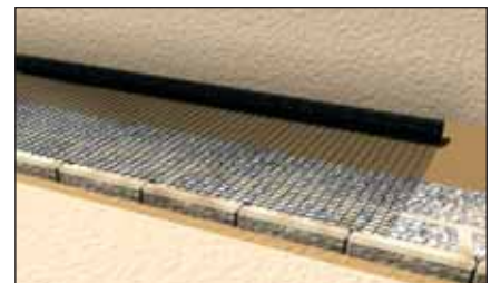
Aanbrengen geogrid
