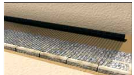
Aanbrengen geogrid
