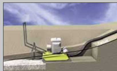
Uitgraven en verdichten volgende trap
