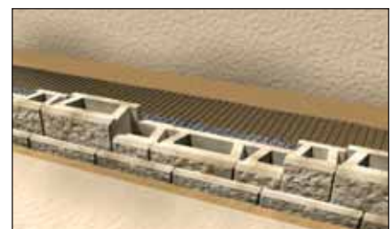
Plaats de eerste rij van de verschillende blokken
